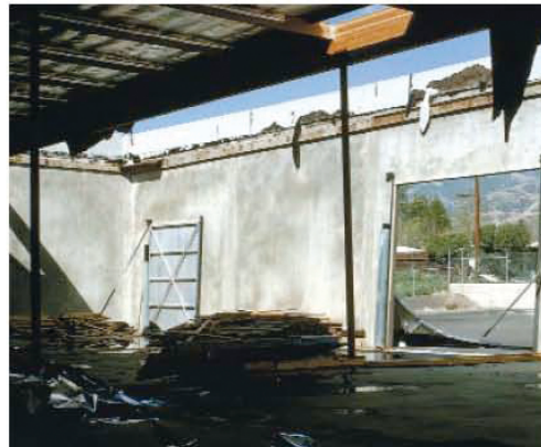
Stetnbrugge Collection, EERC, UCB
