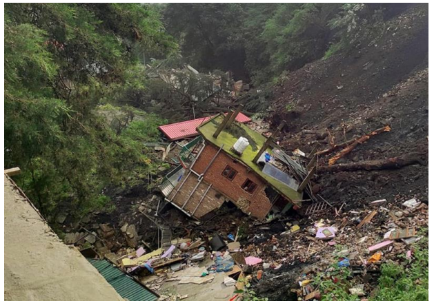
चित्र 2.2.2.3 फिसलने वाले बल के कारण ढहना
