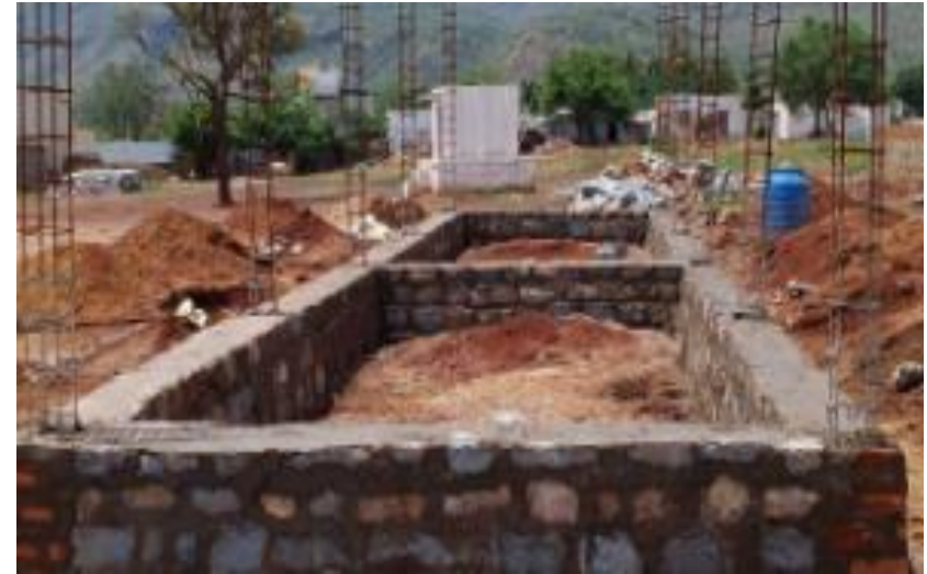
चित्र 6.3.1.8. कोनफाइंड चिनाई प्रणाली में पत्थर की चिनाई
