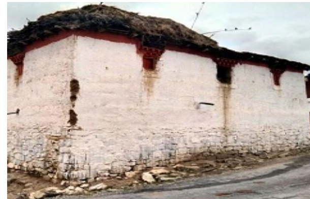
चित्र 6.2.24 पारंपरिक रैम्ड अर्थ हाउस: खराब भूकम्परोधी सुरक्षा और लगातार रखरखाव की आवश्यकता। इसमें कोई भूकम्प बैंड या कोने सुदृढीकरण नहीं है
