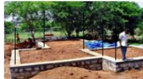
चित्र 6.2.21. प्लिंथ स्तर से 75 मिमी नीचे तक चिनाई जारी रखें और फिर आरसीसी प्लिंथ बैंड प्रदान करें।
