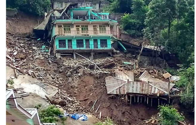
चित्र 2.2.2.1. मिट्टी कटने के कारण उप संरचना को नुकसान
