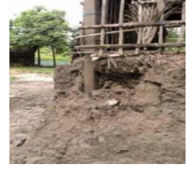
चित्र 2.2.3.3 पानी के बहाव के कारण प्लिंथ को नुकसान
