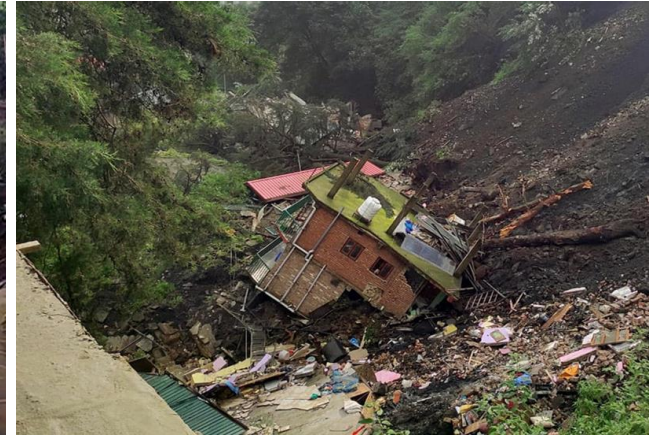
चित्र 2.2.2.3 फिसलने वाले बल के कारण ढहना
