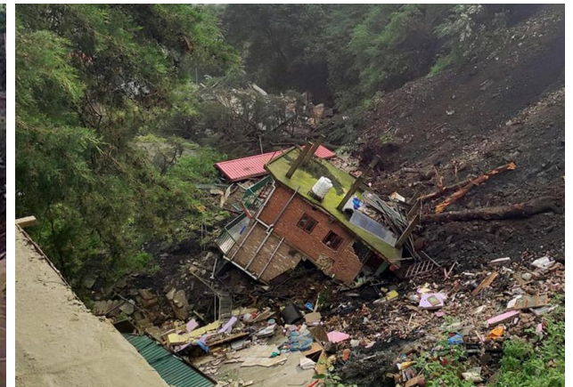
चित्र 2.2.2.3 फिसलने वाले बल के कारण ढहना
