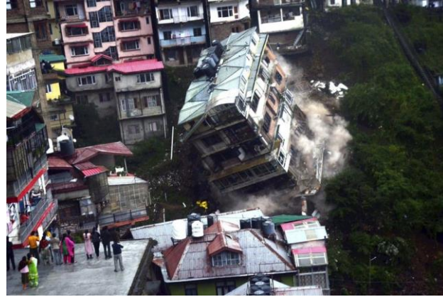
चित्र 2.2.2.1. मिट्टी कटने के कारण उप संरचना को नुकसान
