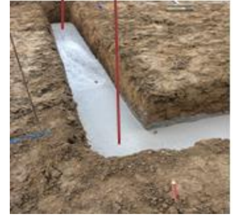
चित्र.6.2.21 आधार कंक्रीट 120mm
