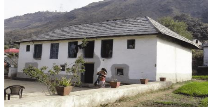
चित्र 2.3.3.2. पारंपरिक घरों में कम लकड़ी के सुदृढ़ीकरण और अपर्याप्त मोर्टार के बढ़ते उपयोग से वे भूकंप, हवा, बारिश के प्रति संवेदनशील हो जाते हैं।
