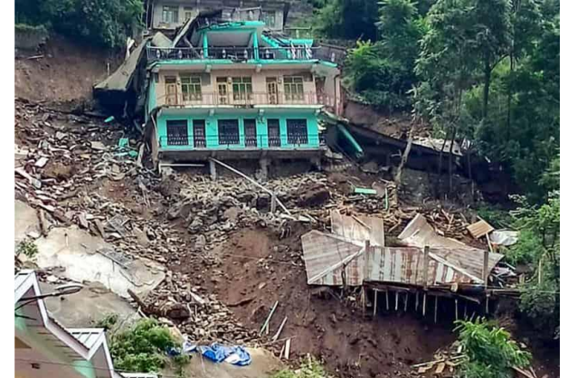
चित्र 2.2.2.1. मिट्टी कटने के कारण उप संरचना को नुकसान
