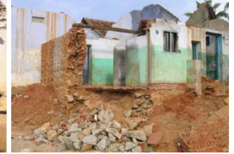
चित्र 2.28 प्लिंथ के नीचे मिट्टी की सफाई को नुकसान
