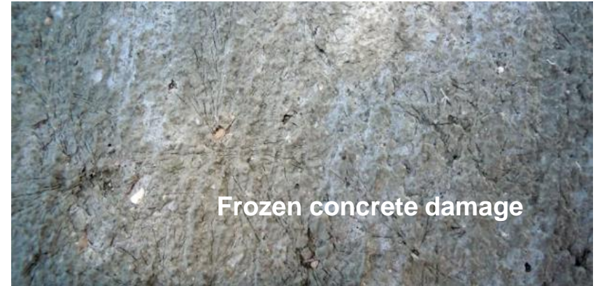
चित्र 6.8. जमी हुई कंक्रीट से होने वाली क्षति
