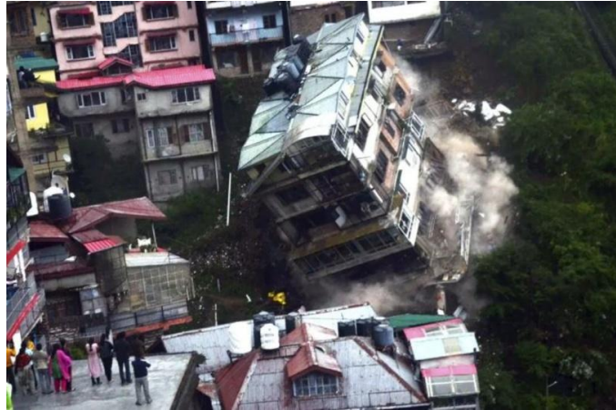
चित्र 2.19. फिसलने वाले बल के कारण ढहना
