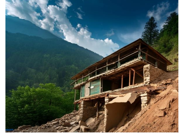
चित्र. 2.18. फिसलने वाले बल के कारण ढहना
