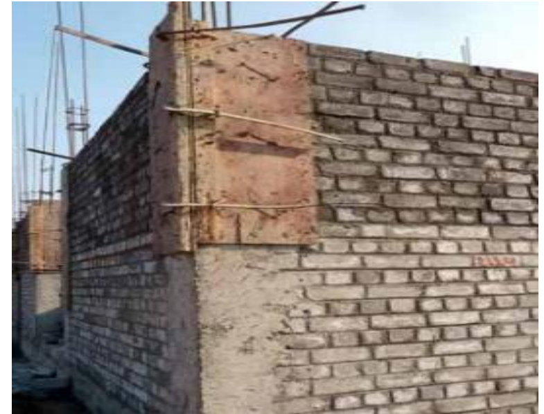
चित्र 3.2.2. मिट्टी की ईंटों का उपयोग करके सीमित चिनाई में शटरिंग
