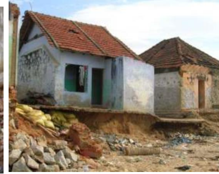
चित्र 2.30 अत्यधिक वर्षा और लहरों के कारण सामग्री के गुणधर्म बदल सकते हैं
