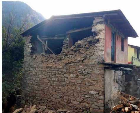
चित्र 2.15. उभार के कारण दीवार को क्षति
